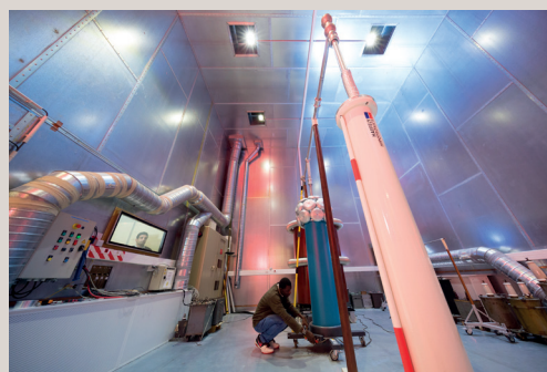
Laboratoire de métrologie électrique haute tension du LNE (300 kV de tension alternative, 250 kV en tension continue, 400 kV en tension de choc de foudre)
